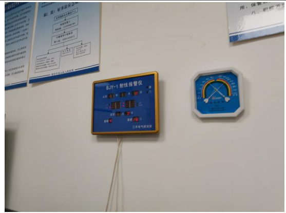
治疗室内固定式剂量报警仪
