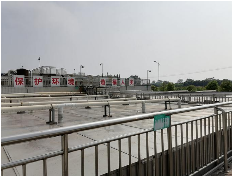
图 3-2 污水处理站 1（已建）
